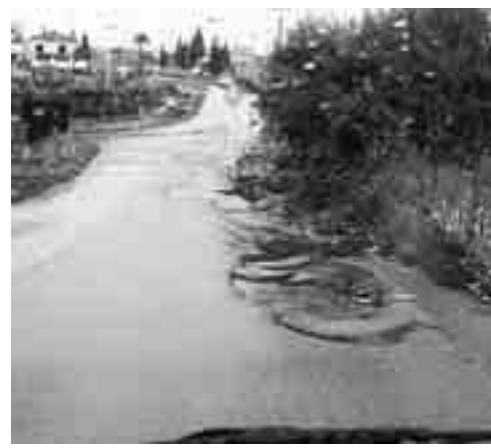
L'ASFALTO STRADALE DETERIORATO
