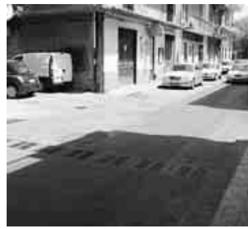
VIA FIUME, UNA DELLE STRADE INTERESSATE DAI LAVORI
